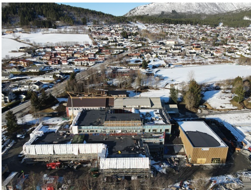
Bygging nye Haukås skole
